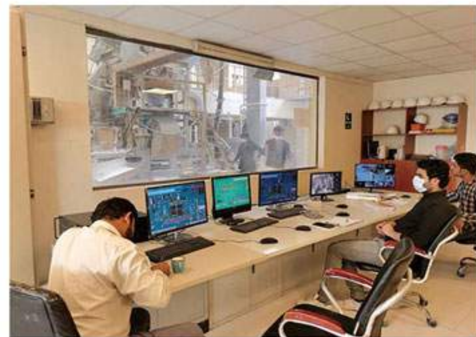
中央控制系统 Central control system
